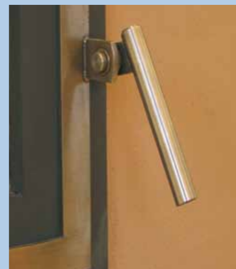
Verschlussgriff aus Edelstahl (Hohlrohr wegen Hitzeentwicklung)
