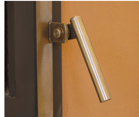
Abb.: Verschlussgriff aus Edelstahl (Hohlrohr wegen Hitzeentwicklung)
